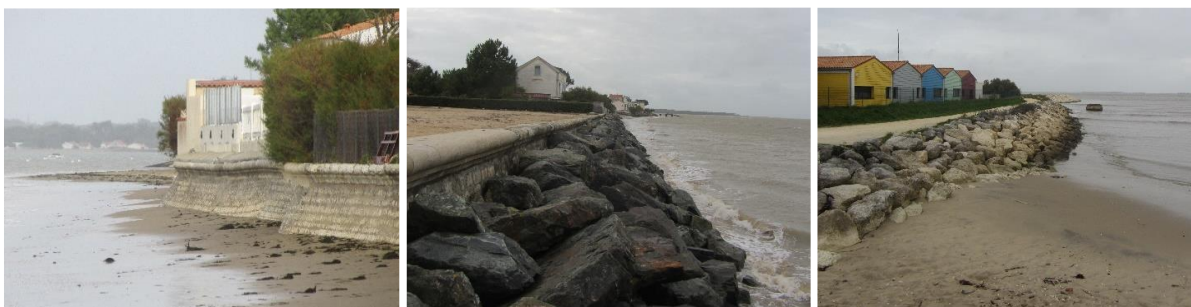
Figure 17 : Mur historique nommé « Brise-lame » (à gauche), « Brise-lame » protégé par enrochement (au milieu) et tronçon Est (à droite) à Ronce-les-Bains (Source : CP 2 )
