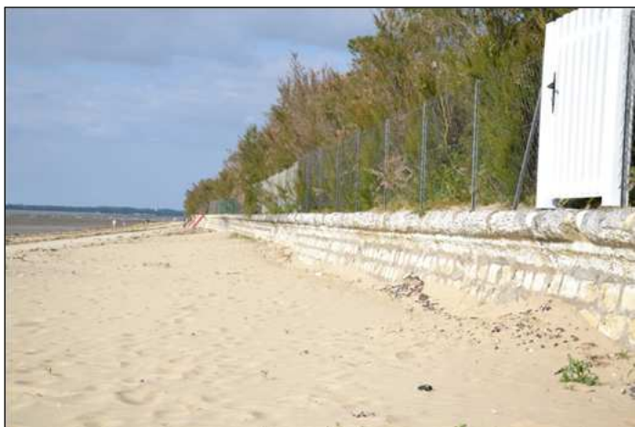
Photo 15. Brise-lame sans enrochement (source : SMASS)
