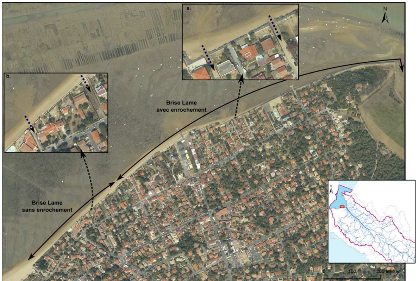
Figure 16. Brise-lame Ronce-les-Bains (source : Orthophotographie 2010)
