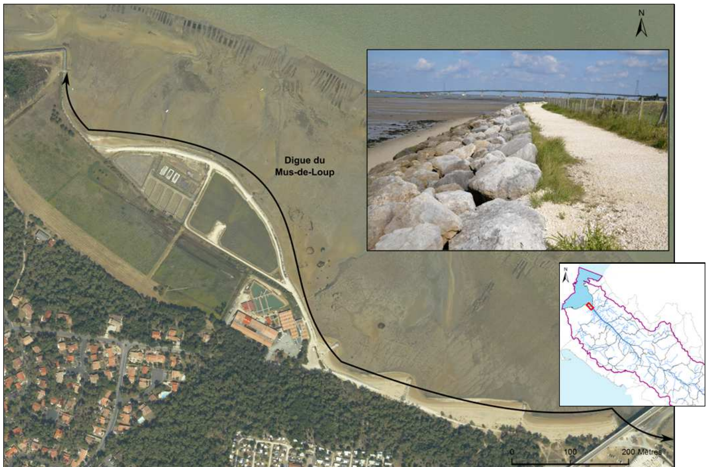
Figure 17. Digue du Mus-de-Loup (source : Orthophotographie 2010 ; photo - SMASS)
