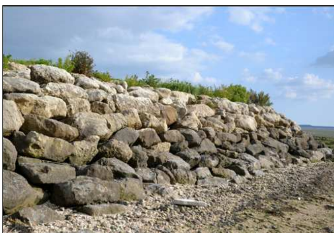
Photo 17. Digue en terre et enrochement (source : SMASS)
