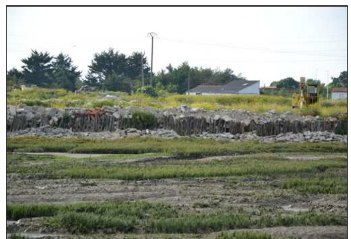
Photo 18. Digue en constructions hétéroclites (source : SMASS)
