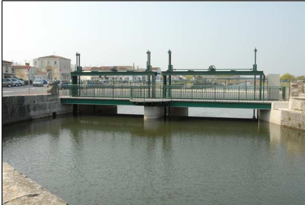
Photo 19. Ecluse de Ribérou (source : SMASS)
